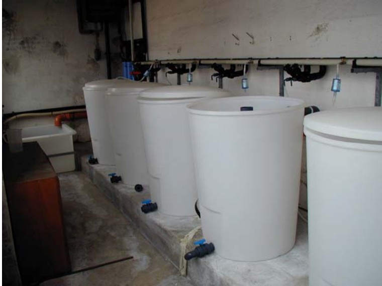
Figur 5.1. Den i 2002 opførte facilitet til hold af fritsvømmende larver i 400 l kar.
