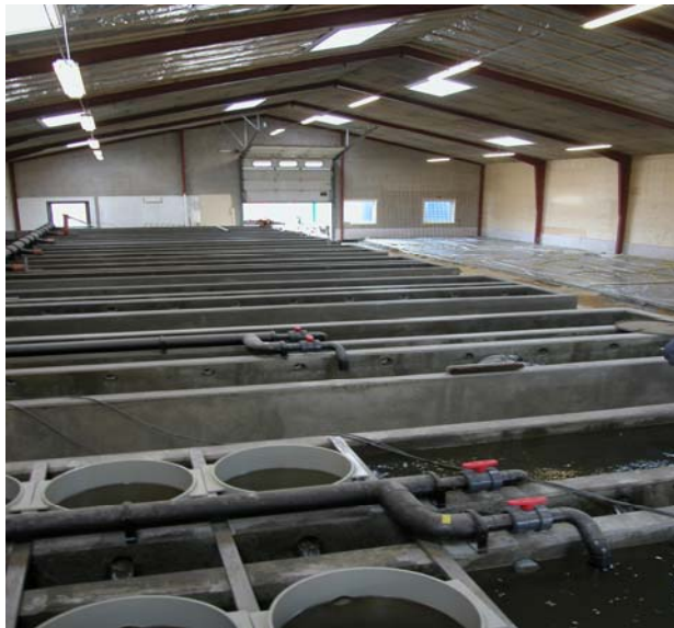
Figur 6.3. Betonkummer med nedsænkede baljer til opvækst af spat.
