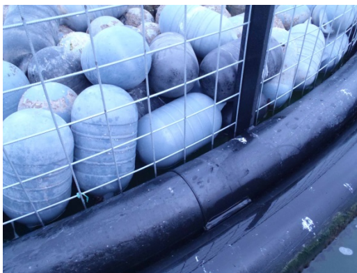
Billede 7. Ny bøjering med sammensvejsede yderringe. På billedet ses også det galvaniserede rionet og en PEH opstander.
